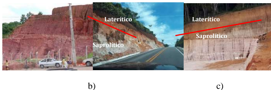
Figura 24. Taludes de corte. a) Horizontes erodíveis (arenoso e siltoso); b) e c) horizontes lateríticos e saprólíticos (altamente erodíveis) (Fotos: N.S. Campelo).
