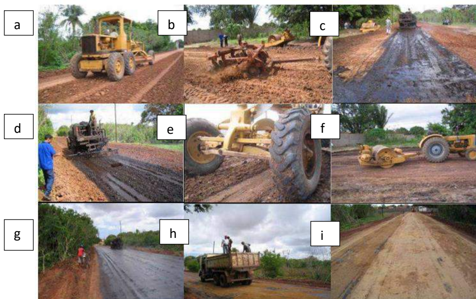
Figura 9. Alguns registros das etapas de execução do trecho experimental com solo-emulsão (Sant’Ana, 2009).
