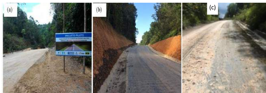
Figura 5. Aspecto final da seção teste. a) 1 dia de conclusão da estabilização, em 10/2016; b) após 490 dias, em 02/2018; c) após 4 anos, em 10/2020 (Almeida, 2018).
