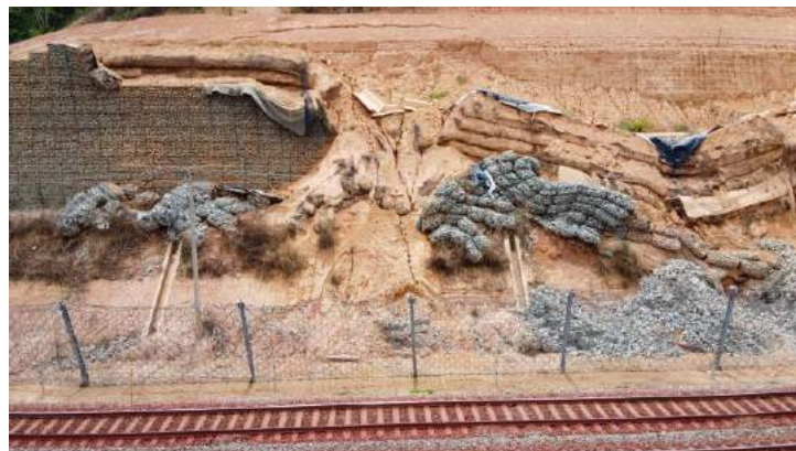
Figura 6: Barreira dinâmica concluída executada para a proteção da ferrovia.
