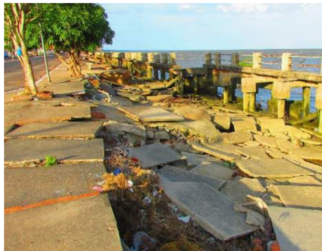
Figura 3. Vista do trecho do muro de contenção - 2019.
