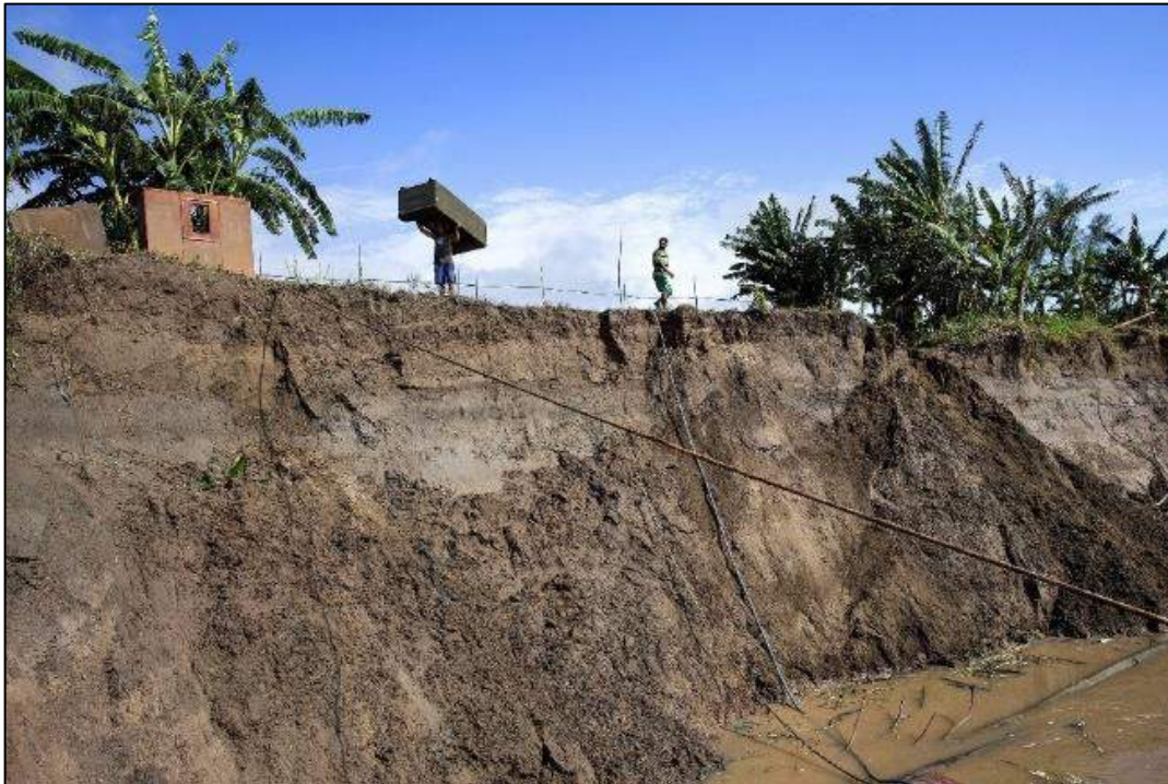
Figura 1. Moradores deixam suas casas, enquanto as terras caídas se aproximam. Fonte: Estarque (2008).
