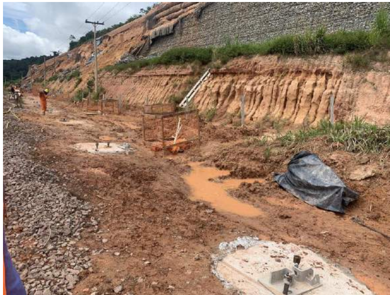
Figura 5: blocos de fundação. Estrutura colpasada ao fundo da fotografia.
