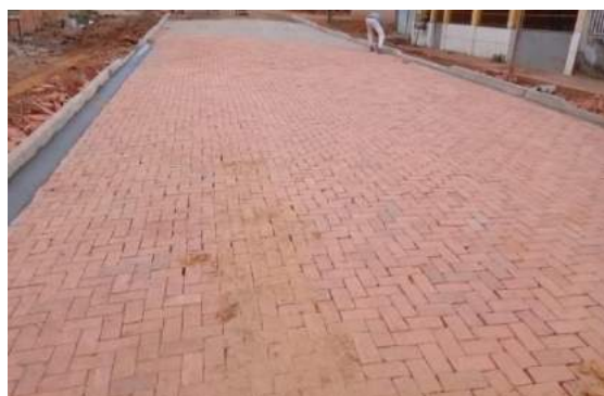
Figura 26. Uso de bloco cerâmico como revestimento de vias urbanas de baixo volume de tráfego (Foto: Jornal AcreAgora ( https://acreagora.com/2021/07/12/ )).
