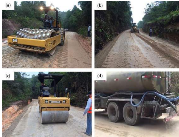
Figura 3. Etapas de (a) compactação; (b) abaulamento; (c) acabamento; (d) cura da camada de solo estabilizado (Almeida, 2018).
