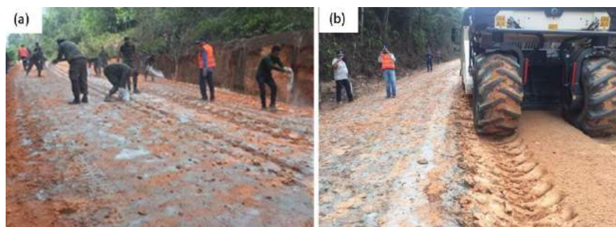
Figura 2. (a) Distribuição do cimento e do aditivo ZS na pista experimental por espalhamento manual; (b) homogeneização do solo, cimento e aditivo ZS “in situ”, por meio de recicladora (Almeida, 2018).
