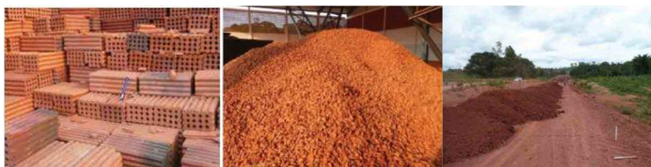
Figura 6. Emprego de AGSAC em pavimentação: a) Confecção dos blocos cerâmicos com temperatura de queima controlada; b) britagem dos blocos cerâmicos; c) empilhamento da mistura de solo laterítico e AGSAC no campo (Cabral, 2011).
