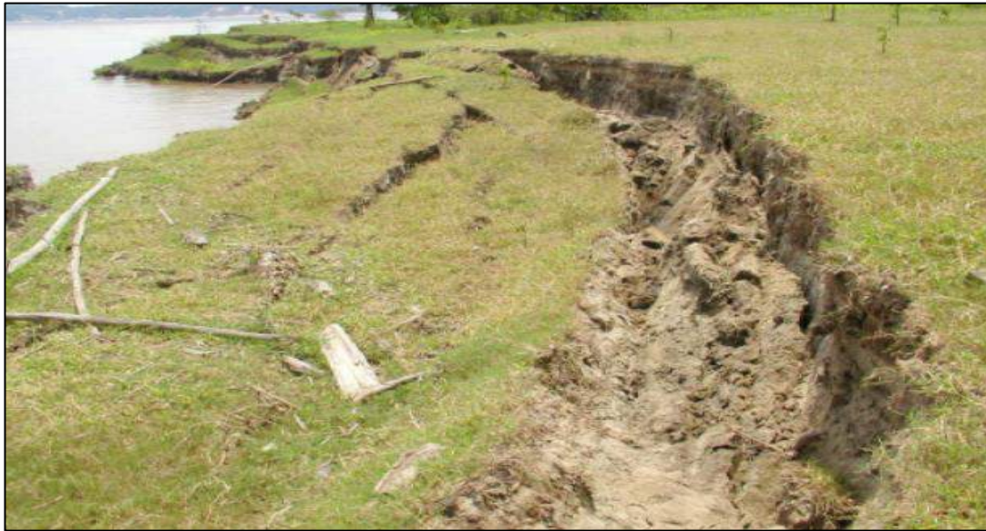
Figura 2. Exemplo de escorregamento, no Careiro/AM. Fonte: Nunes (2004) apud Carvalho (2006).
